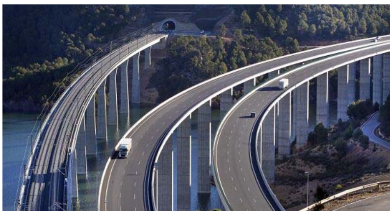
La vía del AVE Madrid-Valencia, en un tramo que discurre junto a la carretera Nacional 3. / CARLES FRANCESC
